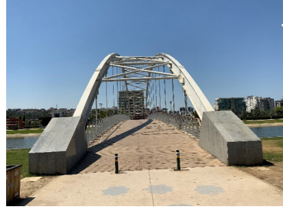
Şekil 4.6 Yaya köprüsü (ŞİMŞEK, 2023-Orijinal)
