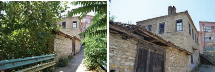
Resim 21-22. Bakır Evi Sokak Cephesi
