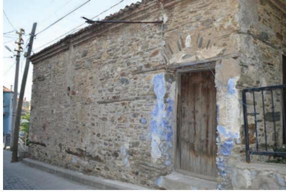
Resim 24. Bakır Evi sokak cephesi
