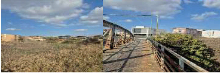
Resim 3.5. Muratlı Lise Köprü
