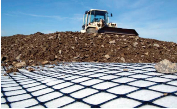
Şekil 16. Geotekstil- geogrid kompozit uygulaması
