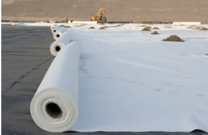
Şekil 15. Geotekstil- geomembran kompozit uygulaması
