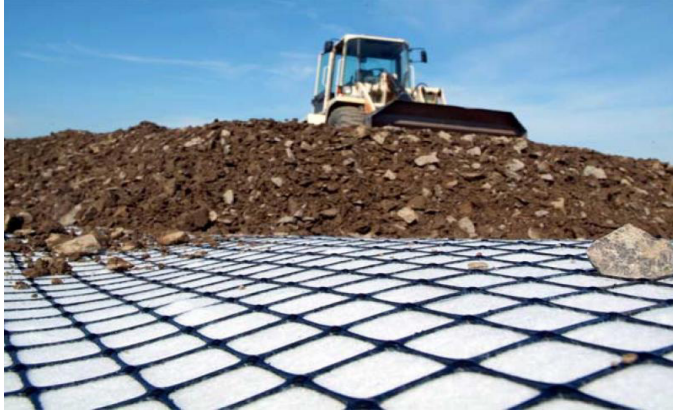
Şekil 16. Geotekstil- geogrid kompozit uygulaması
