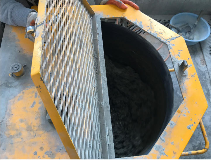
Şekil 3.3. Betonun karışma hali
