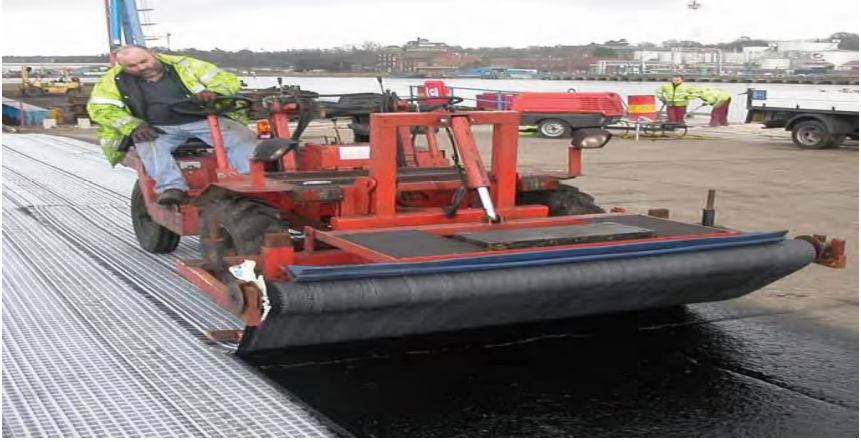
Şekil 15. Bitüm püskürtülmüş mevcut yolun üzerine geotekstil + geogrid kompozitinin serilmesi
