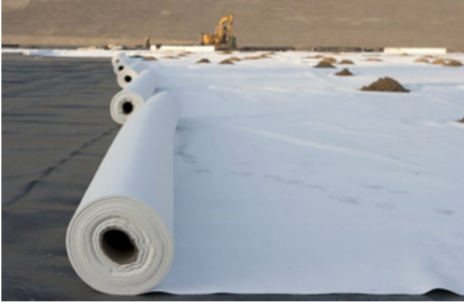
Şekil 15. Geotekstil- geomembran kompozit uygulaması
