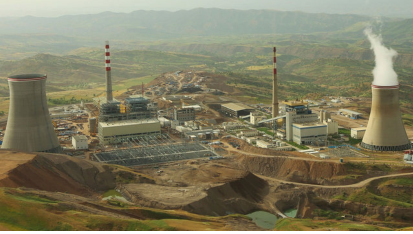
Şekil 6. Silopi Termik Santrali (URL-5).
