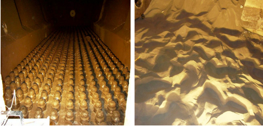
Şekil 5. Primer Havanın Verildiği Nozul Tabanı ve Yatak Malzemesi (URL-3).
