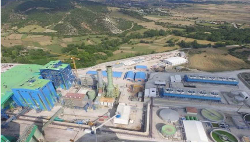
Şekil 8. Bolu Göynük Termik Santrali (URL-9).
