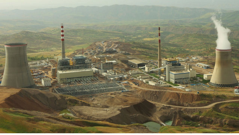
Şekil 6. Silopi Termik Santrali (URL-5).
