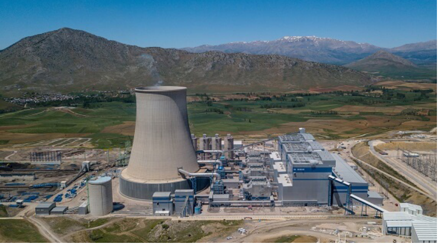
Şekil 9. Enerjisa Tufanbeyli Termik Santrali (URL-10).
