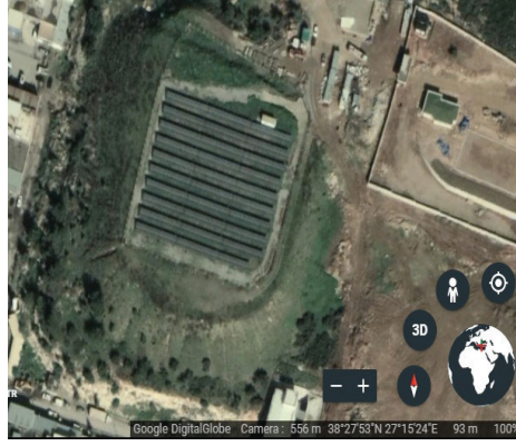
Şekil 5. GES'e ait genel görünüm
