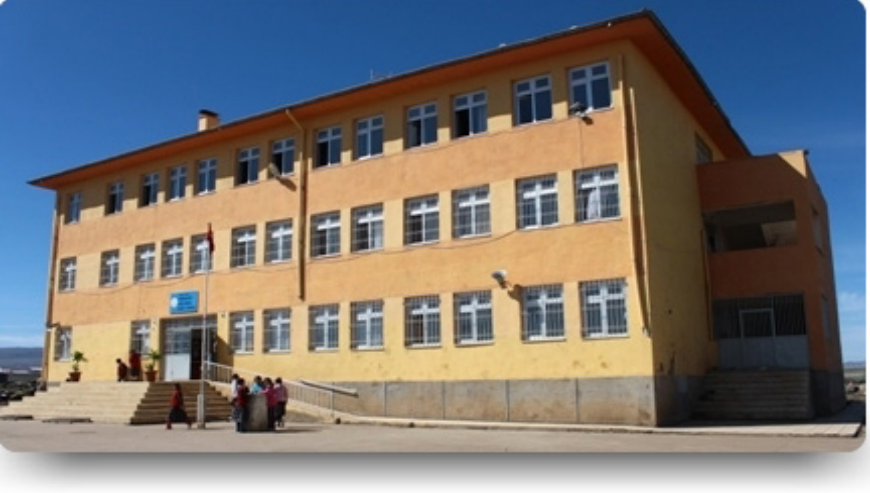
Őekil 5. Okul binası
