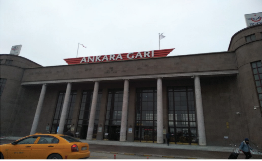
Fotoğraf 4: Ankara Garı, giriş cephesi
