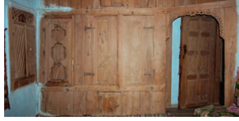
Fotoğraf 30: Kuzeybatı oda dolapları
