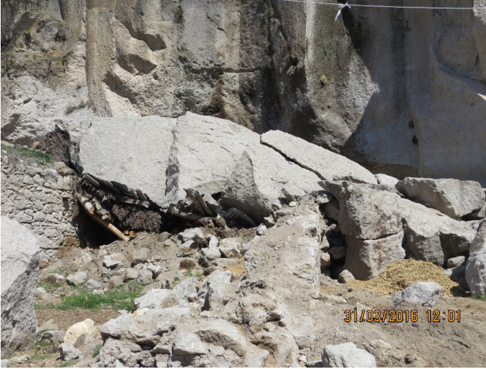
Fotoğraf 12. Sarıkavak Mevkiinde Kaya Düşmesi Sonucu Tahrip Olmuş Ağıl.
