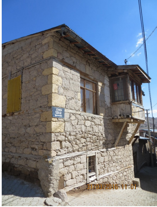
Fotoğraf 4. Taş ve Ahşap Malzeme ile Yapılmış Mesken.
