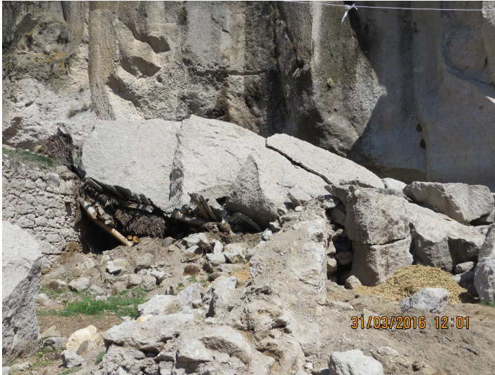
Fotoğraf 12. Sarıkavak Mevkiinde Kaya Düşmesi Sonucu Tahrir Olmuş Ağıl.
