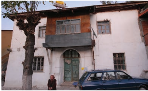
Fotoğraf 2: Batı cephe.
