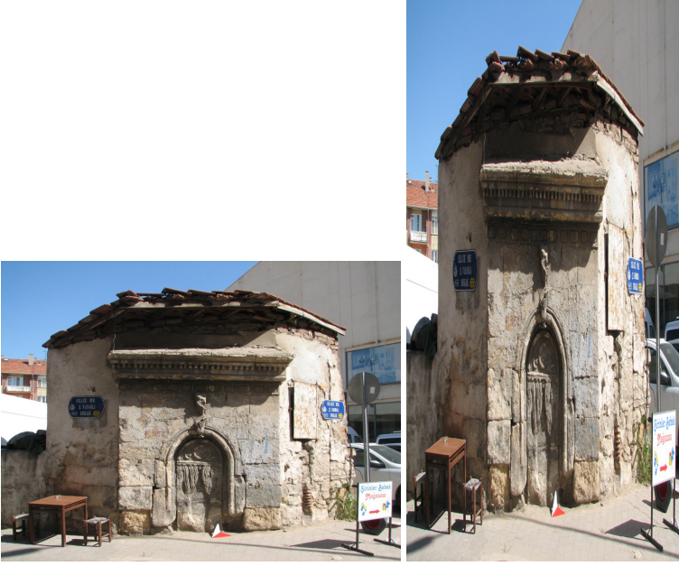
Fotoğraf 34. Uşak Merkez. Vidinli Sokak Çeşmesi.
