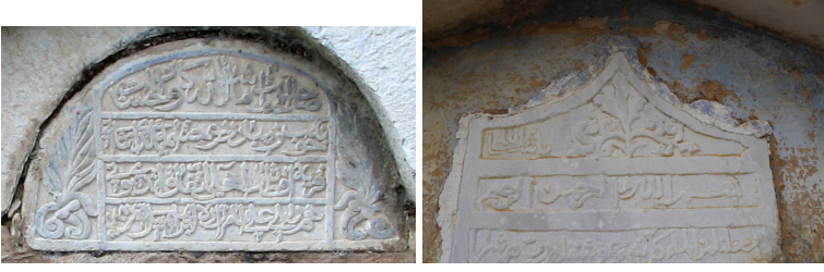
Fotoğraf 8-9. Merkez Köyler, Aktaş Köyü Aşağı Çeşme ve Merkez Köylerden Ortaköy'deki Kabaca Çeşme'nin Kitabelerinden Detay.
