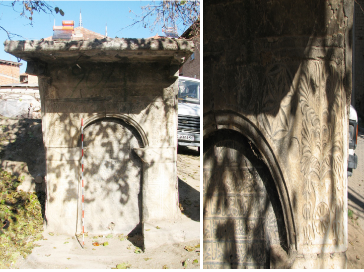
Fotoğraf 12. Sivasslı İlçesi, Selçukler Beldesi'ndeki Hacıoğlu Çeşmesi. Kemer Köşeliğinden Detay.
