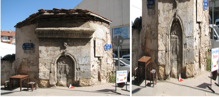
Fotoğraf 34. Uşak Merkez. Vedinli Sokak Çeşmesi.
