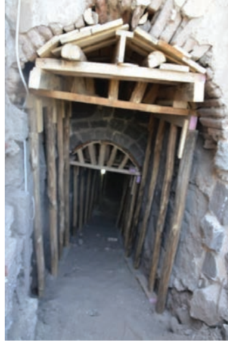
Fotoğraf:25- Tünelde Yapılan Askılama Çalışmaları.
