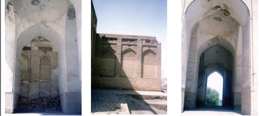
Resim 14. Buhara Namazgâhı, batı duvarın güneyi./ Resim 15. Buhara Namazgâhı, batı duvarın kuzeyi./ Resim 16. Buhara Namazgâhı, güney cephesi.
