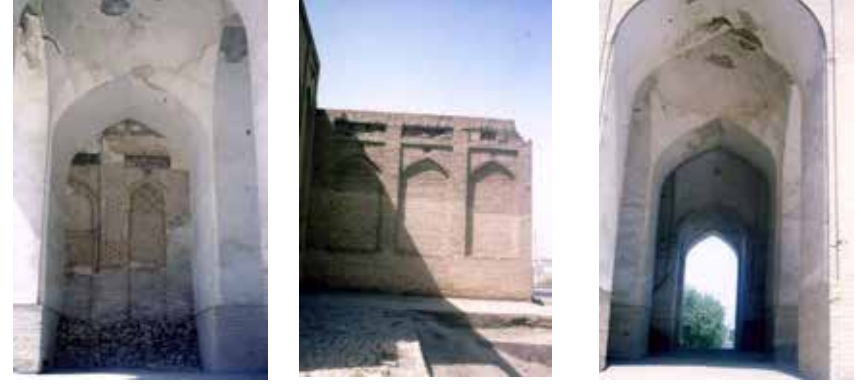
Resim 14. Buhara Namazgâhi, batı duvarın güneyi./ Resim 15. Buhara Namazgâhi, batı duvarın kuzeyi./ Resim 16. Buhara Namazgâhi, güney cephesi.
