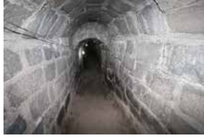
Fotoğraf: 24- Sarayın Kaçış Tünelinin İçten Görünüşü.
