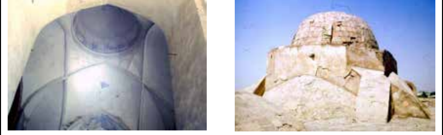
Resim 17. Buhara Namazgâhı, üst örtü içten güney - kuzey yönden./ Resim 18. Buhara Namazgâhı, üst örtü dıştan güney - kuzey yönden.
