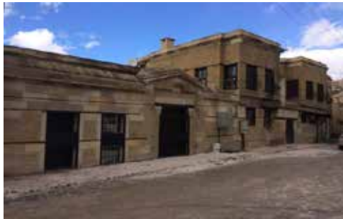
Fotoğraf 16. Cullaz sokak Goncü Konağı.
