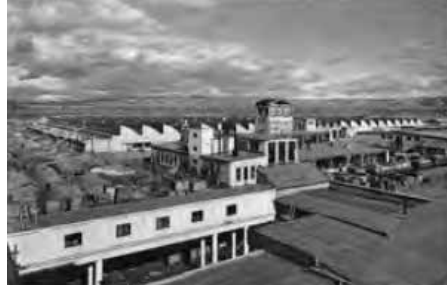
Şekil 4. Sümerbank Bez Fabrikası ve Lojmanları, Kayseri
