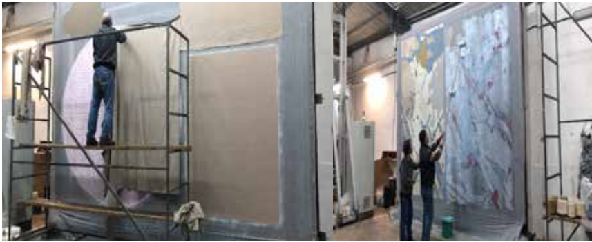
Şekil 18: halı sırtına tutkal sürülmesi ve ikinci tabanın yapıştırılması 10
