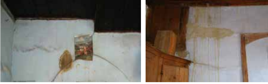
Şekil 23. Ayşe Sezgin Evi'nin duvar görünümleri.
