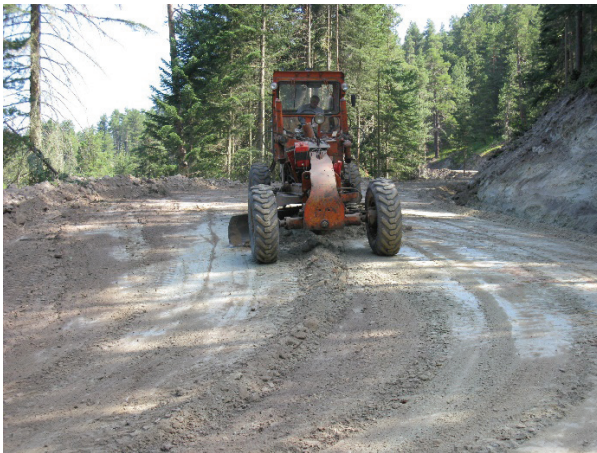
Şekil 11. Yol ince tesviyesinin yapılması (Foto: T.Öztürk)
