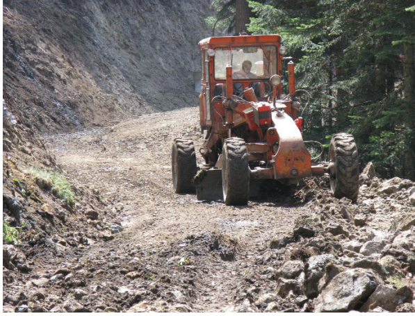
Şekil 13. Yol yapım ve bakım çalışmalarında kullanılan greyder (Foto: T.Öztürk)
