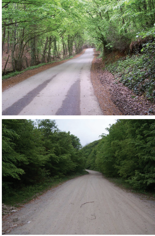
Şekil 2. Dere kenarına inşa edilmiş orman yolları (Foto: T.Öztürk)
