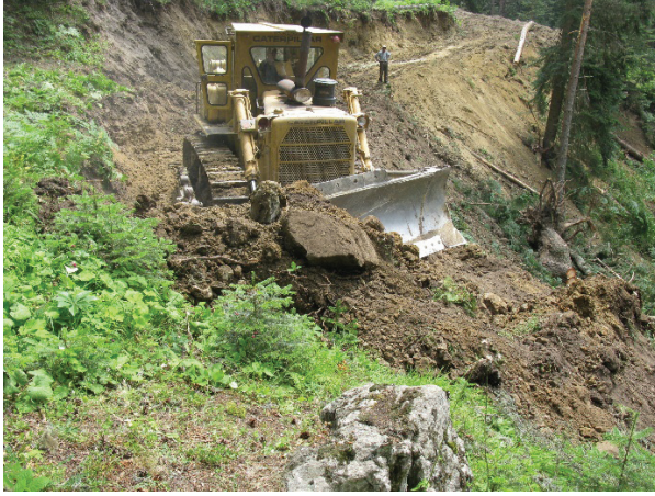
Şekil 10. Buldozerle kazı çalışmaları (Foto: T.Öztürk)
