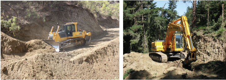
Şekil 12. Orman yollarında kullanılan buldozer ve ekskavatörler (Foto: T.Öztürk)
