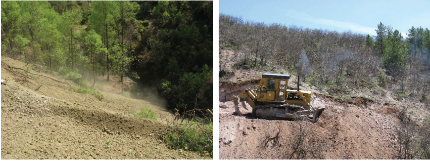
Şekil 16. Kazı materyali ile dere yataklarının doldurulması (Foto: T.Öztürk)
